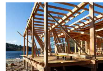
Eksempel på træskeletkonstruktion
