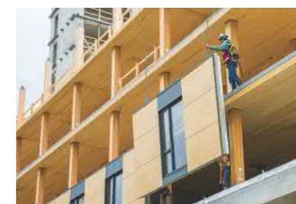
Eksempel på hybridkonstruktion med lette facader
