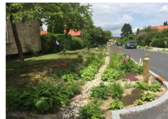
Grønt regnbed som hastighedsdæmper. Virum, SWECO
