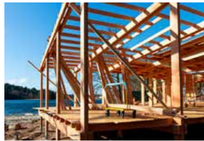
Eksempel på træskeletkonstruktion
