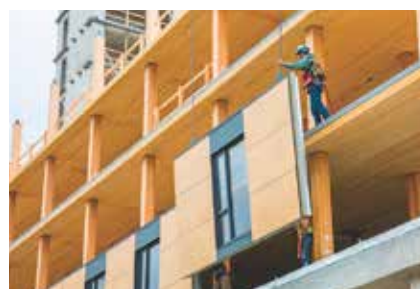
Eksempel på hybridkonstruktion med lette facader
