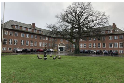
Filadelfias administrationsbygning, beliggende i det parklignende område nord for lokalplanområdet.
