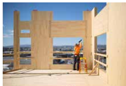
Eksempel på massivtræelementer / CLT
